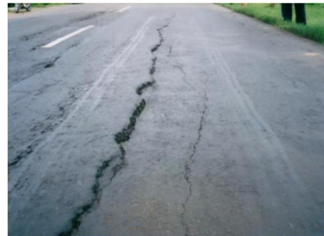
（写真：（左）多孔質コンクリート製品／北海道ポラコン(株)、（右）道路舗装破壊の様子／インドネシア公共事業省）
